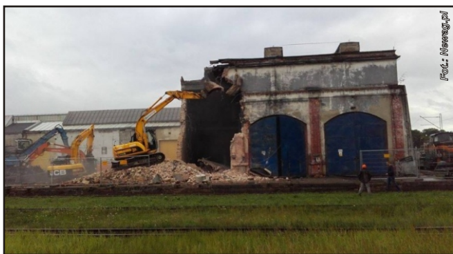
Prace rozbiórkowe na terenie sądeckiego Nowagu
