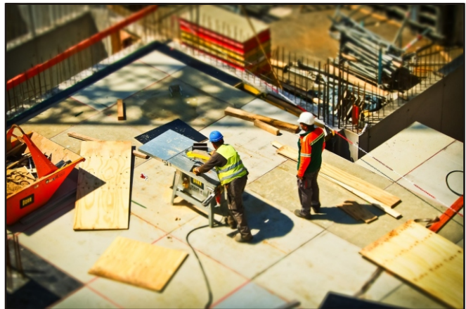
Prace na budowie, fot. pixabay.com
